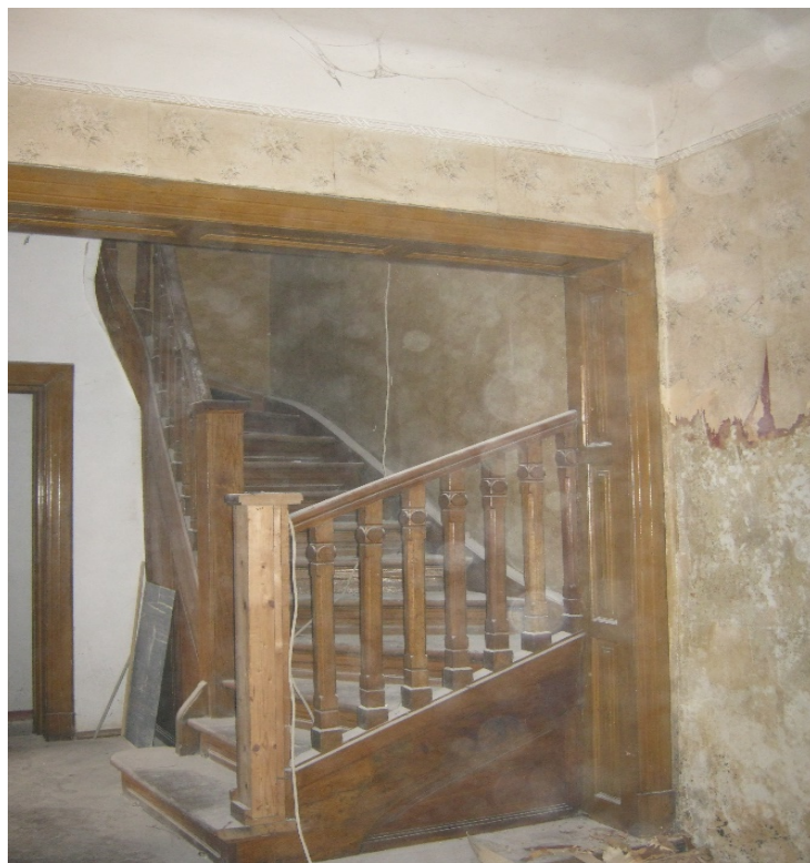
Tâmplărie interioară – înainte de restaurare
